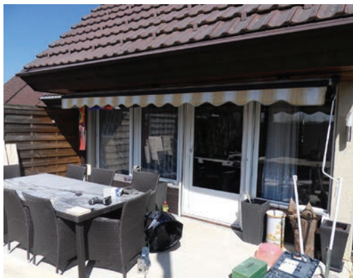
Anstelle des ungedeckten Sitzplatzes entsteht ein gemütlicher Wintergarten.
