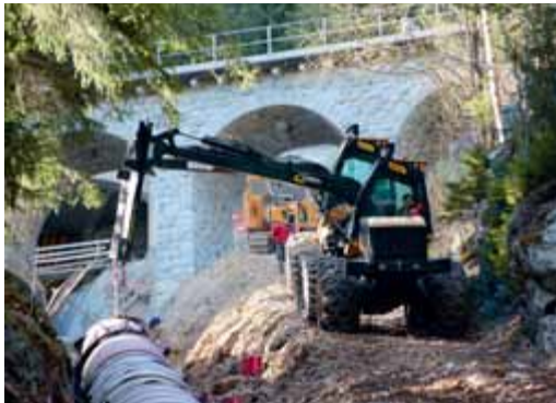
Verlegung von Stahlrohr 10 t
