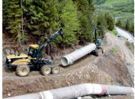
Rohrtransport mit ECOLOG
