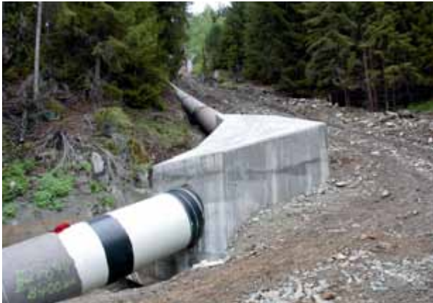
Betonierter Fixpunkt 1
