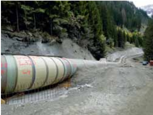
Verlegung von Stahlrohr 10 t
