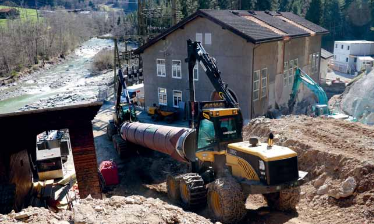
Rohrtransport mit ECOLOG
