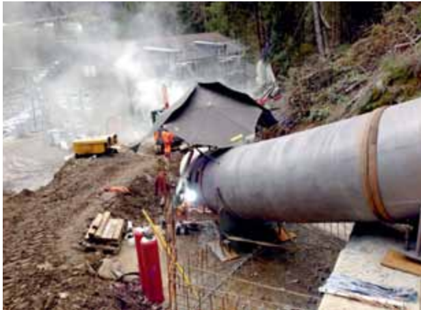
Schweissarbeiten am Fixpunkt 1
