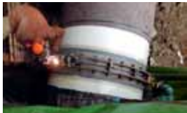
Schweissarbeiten in Zentriervorrichtung
