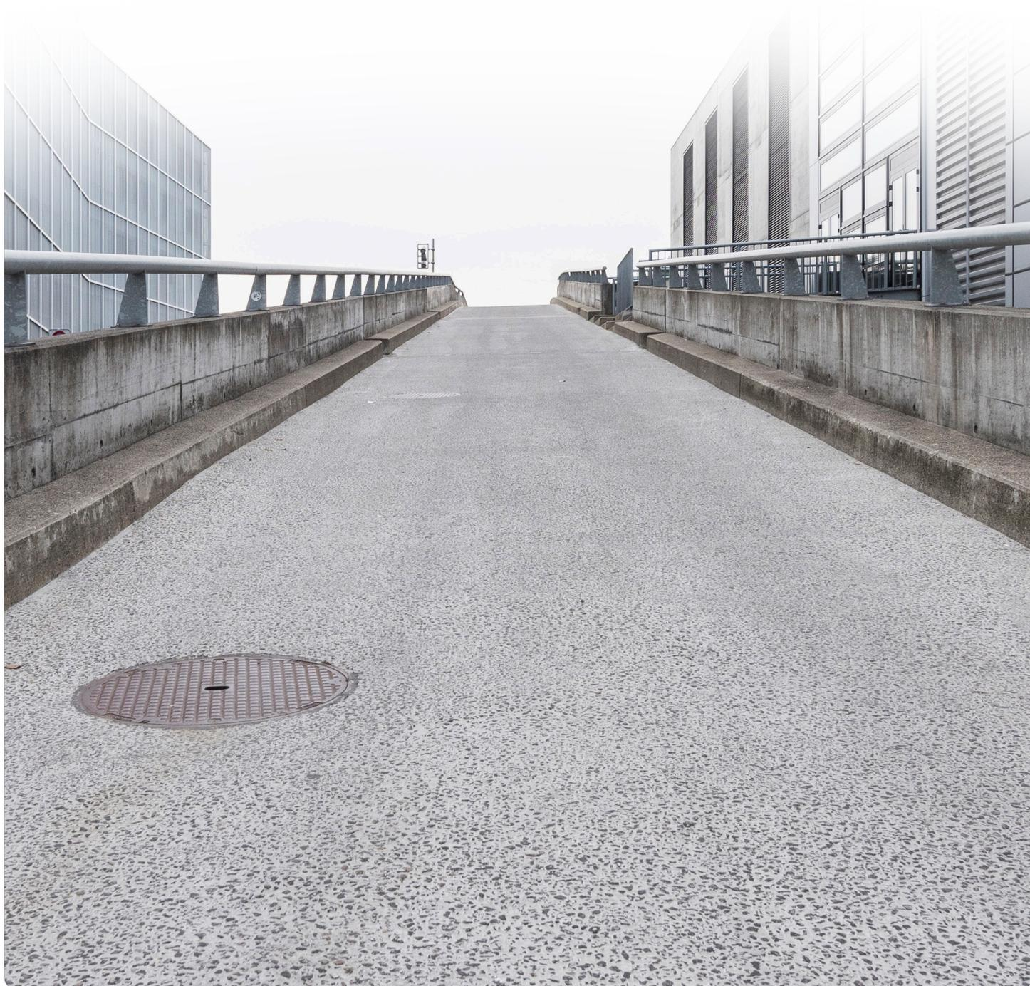
Le revêtement de mortier BITUZIM allie les propriétés flexibles d'un revêtement bitumeux mélangé à chaud et la stabilité d'un béton de ciment. Un badigeon synthétique spécial à base de ciment est introduit par vibration dans les cavités du mélange
