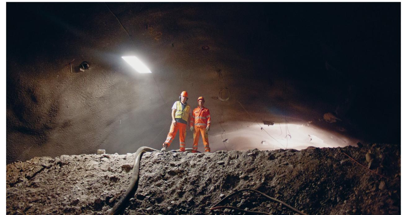
Der Ceneri-Basistunnel verbindet seit 2020 den nördlichen mit dem südlichen Teil des Tessins. 16 Tage verbrachte eine Equipe von Weiss+Appetito 2018 im Tunnel und blies mit dem Power Jumbo 3000 Kubikmeter Kies in einen Fensterstollen, der als Zugang für die Arbeiten am Haupttunnel gedient hatte.
