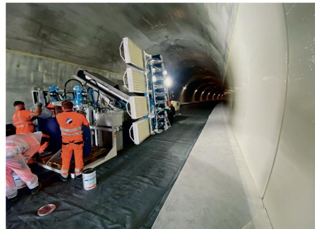
*Entwicklung einer individualisierten Tunnelbeschichtungsanlage.*
