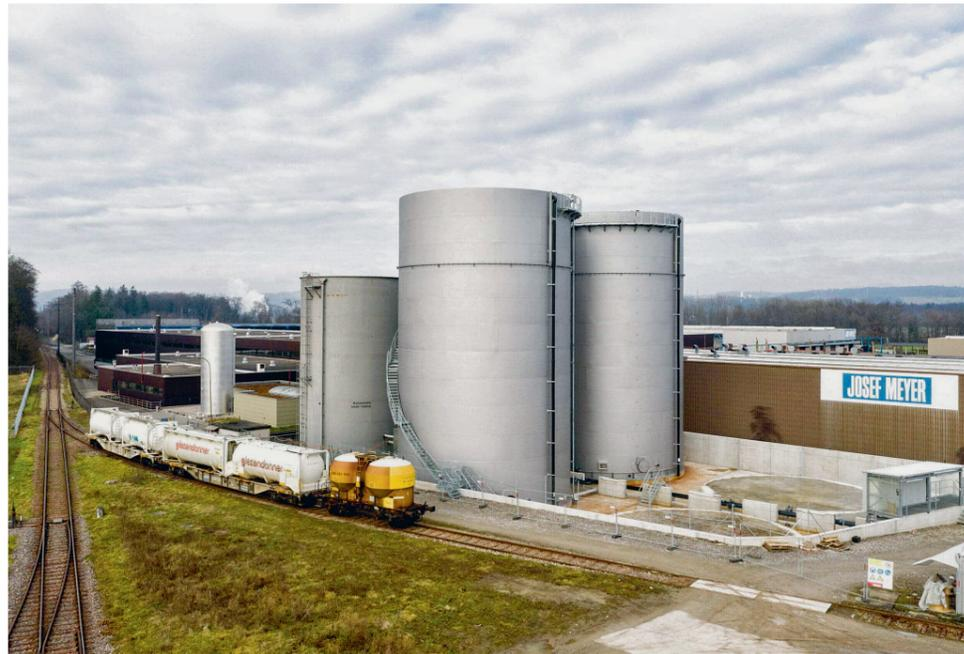
*Oben: Fertigung von zwei neuen Tanks mit einer Gesamthöhe von 24 Metern und einem Durchmesser von 14 Metern für die Salinen AG.*
