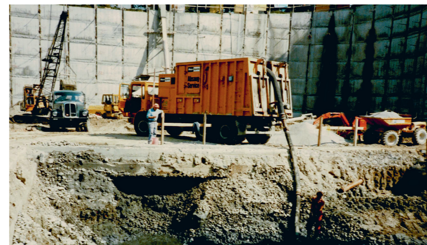
En 1982, le camion aspirateur «VAC Truck» est mis en service. Avec ce véhicule, la société Weiss+Appetito peut aspirer toutes les substances dans un rayon de 200 mètres et à des profondeurs de plus de 40 mètres.
