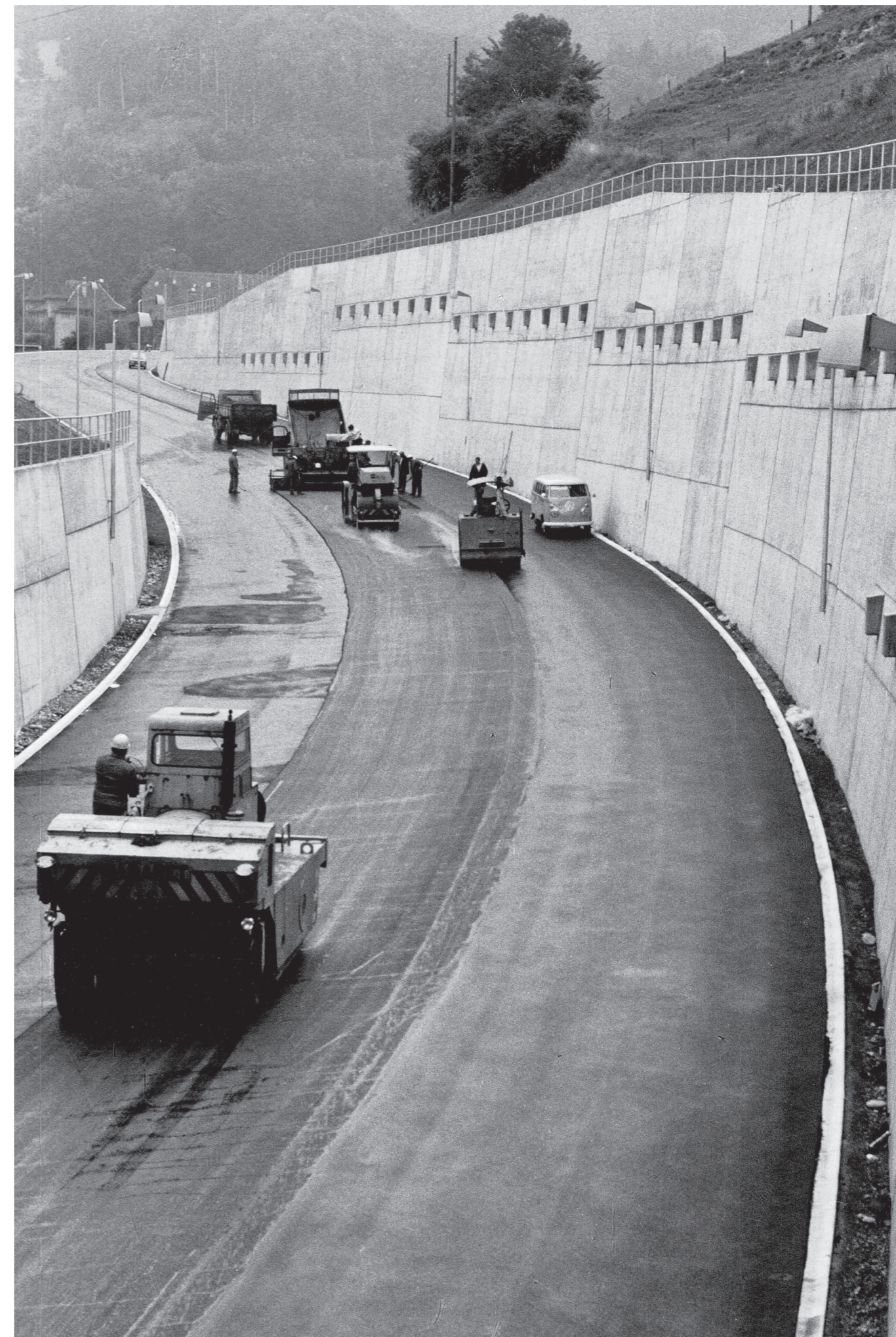
Construction de la route de délestage de Kehrsatz, 1968-1970.
