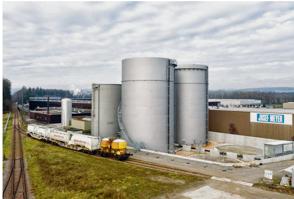
En haut: Fabrication de deux nouveaux réservoirs d'une hauteur totale de 24 mètres et d'un diamètre de 14 mètres pour Salinen AG.
